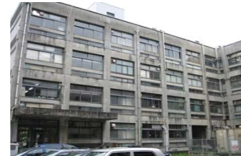
耐震性の低い施設の外観
