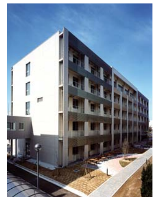
図 2-6 医学部保健学科本館改修
