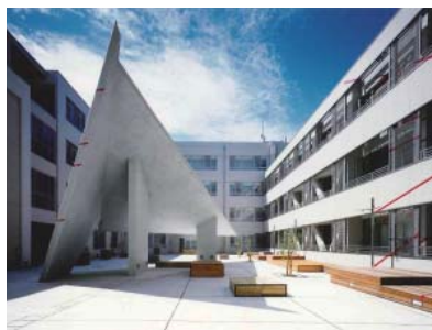
図 2-3 全学教育棟改修
