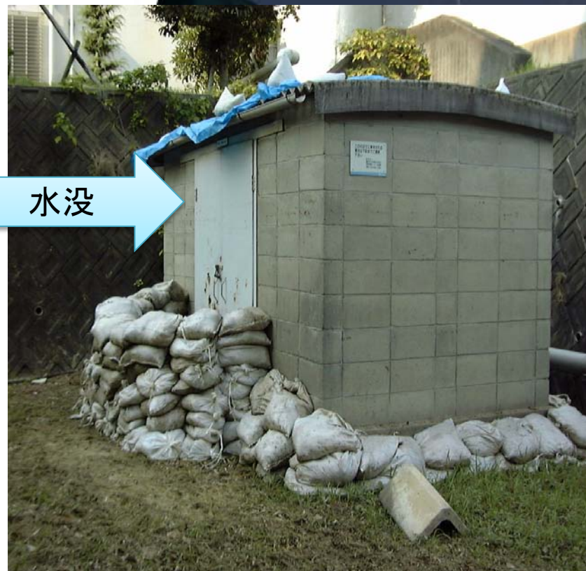
ガスガバナ水没 ガス漏れ
