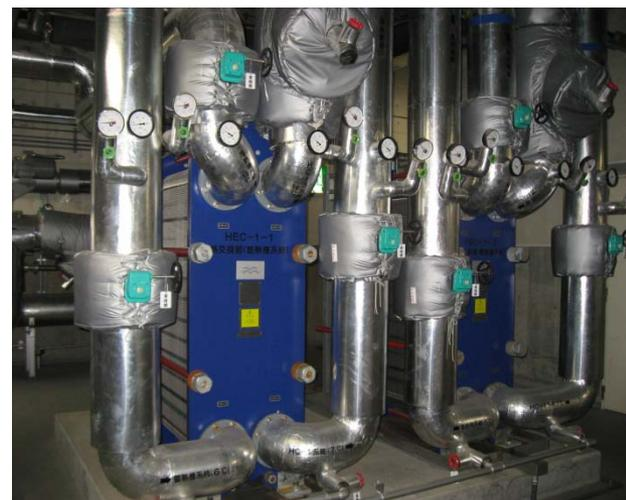
中診棟 蒸気-温水プレート式熱交換機
