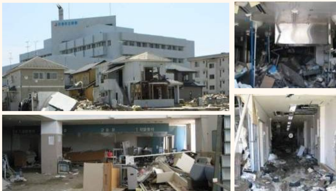
石巻市立病院の被災状況
