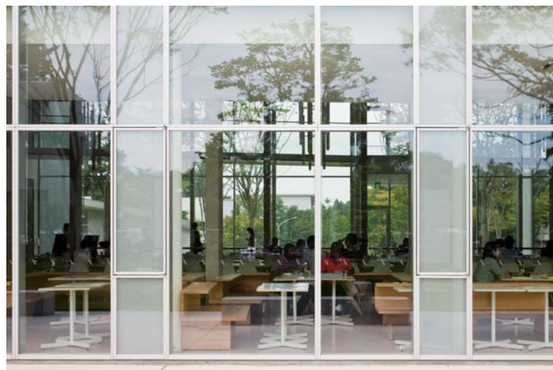
南面のガラスカーテンウォールのファサード
