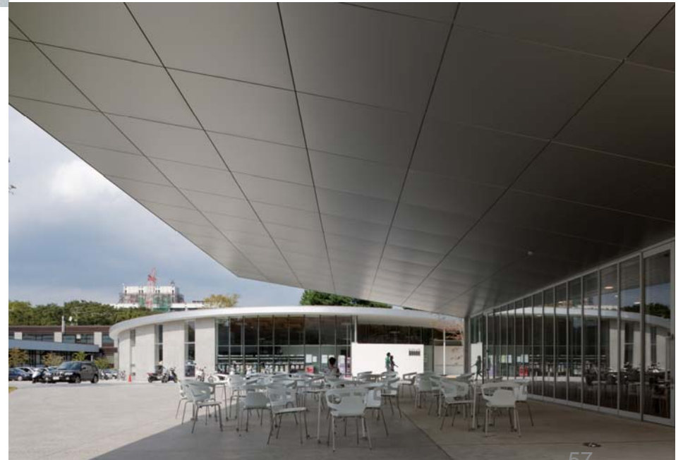
ダイニング2テラスより、ブックカフェ棟を望む
