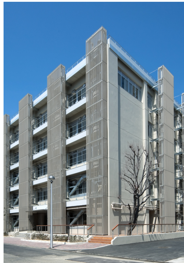
理学部E館：南面（改修）
