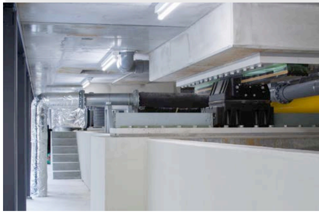
固有周期5.2秒、クリアランス900mm、南海トラフ巨大地震に堪える安全性
