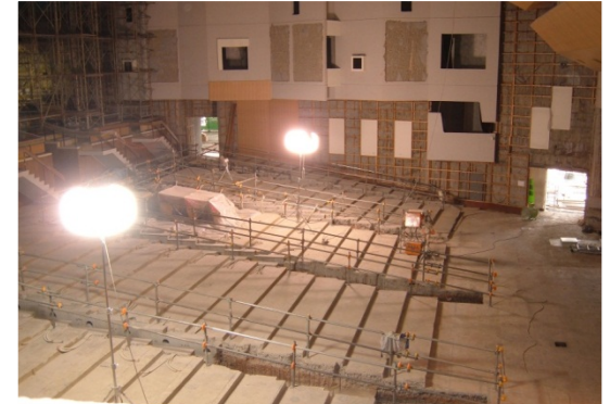
床下空調ダクト工事
