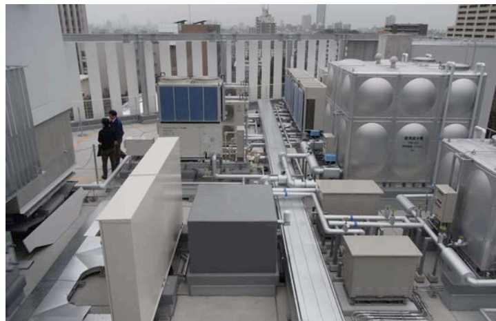
屋外機置場：都市ガス・プロパン切替型GHP(非常電源対応).デシカント外気処理ユニット
