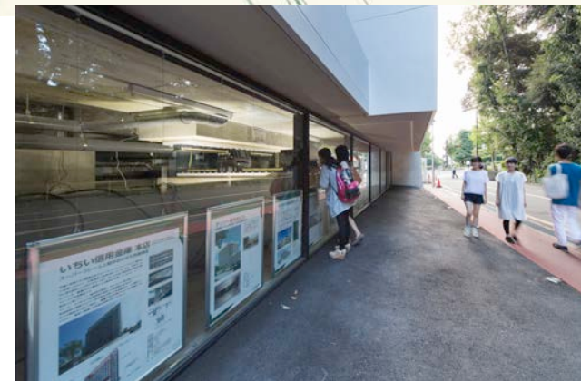
ピット階・免震ギャラリー：3種の免震部材、変位計、加速度計を設置。
