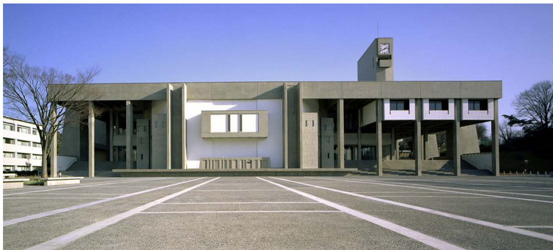
改修後 打放面の意匠性回復，汚れ防止技術の適用，前庭の全面改修
