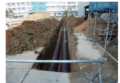
アースチューブの埋設工事
