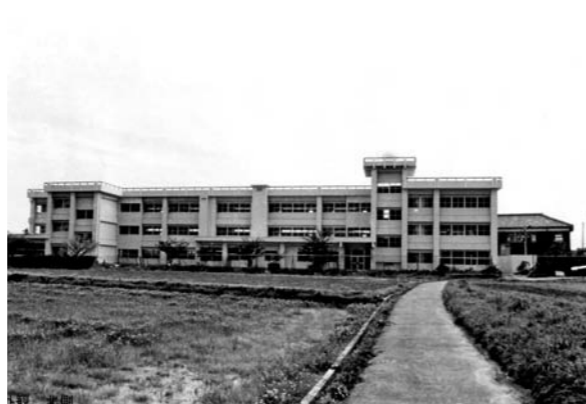
昭和50年に完成した鉄筋コンクリート校舎 (石榑小学校提供)
