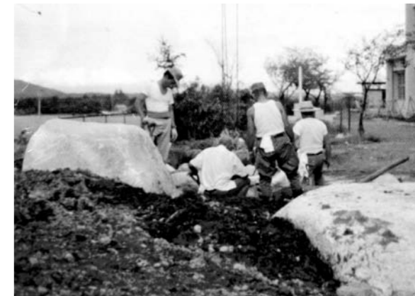
地元の人々による造園工事 (石榑小学校提供)
